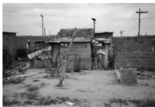
Casa com coberturas diversas (telhas de barro e papelão)
