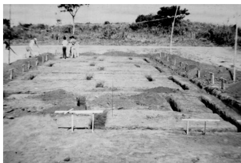
Figura 04: Fundação de uma casa
