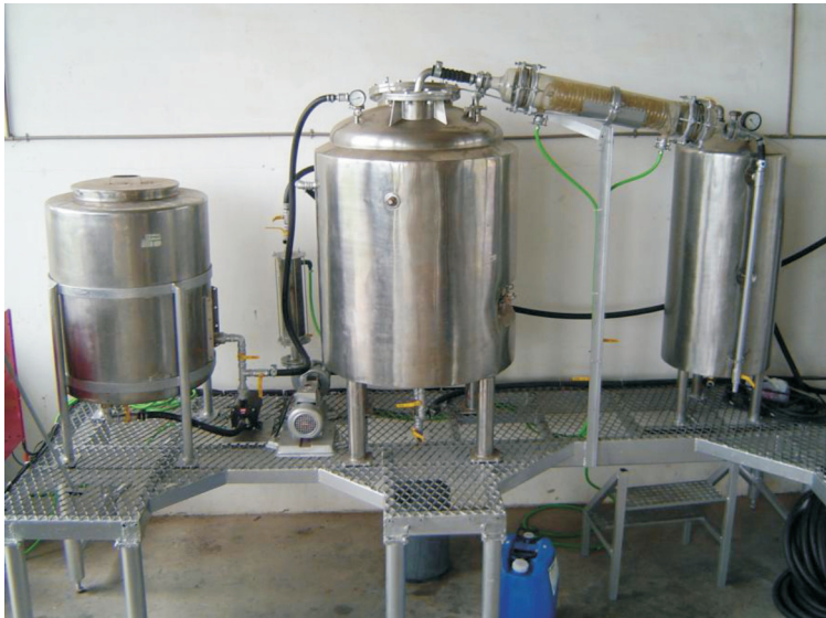
Figura 3. Equipamentos utilizados na usina (em processo de reforma) da UENF. Da esquerda para direita, tanque da mistura, destilador, condensador e aquecedor.
