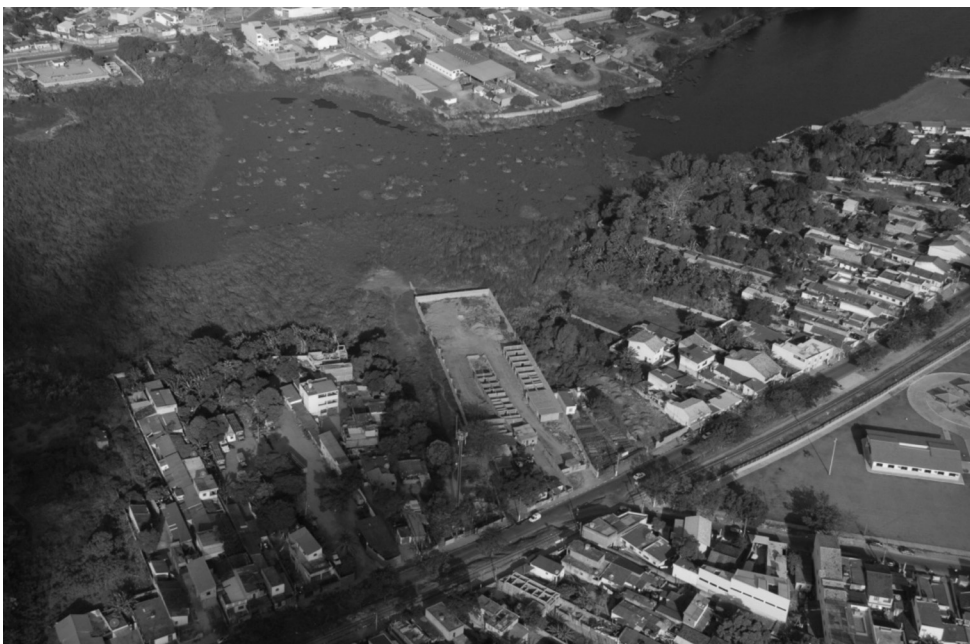
Figura 3 – Lagoa do Vigário – A ocupação desordenada
