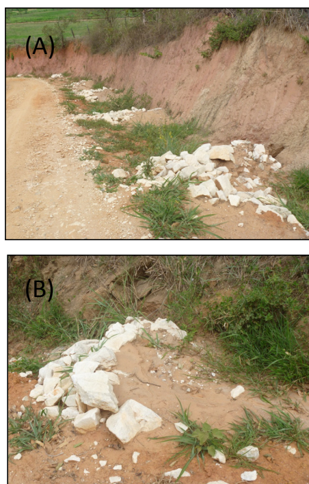
Figura 3 – Fotografias ilustrativas das estruturas utilizadas: (A) Disposição das estruturas em série e instaladas na margem; (B) Detalhe da estrutura do tipo “bacia de retenção”
